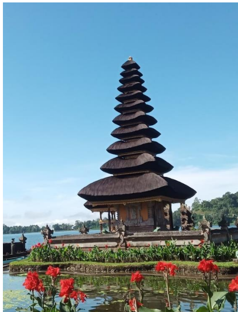
Gambar 1. Bangunan Pura Ulun Danu
