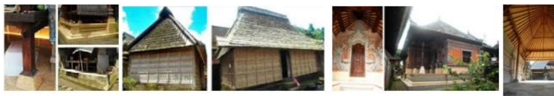
Gambar 4. Bebaturan, dinding, tembok, dan raab
